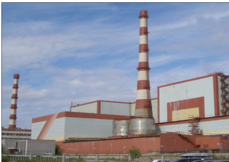
Кольская атомная станция
